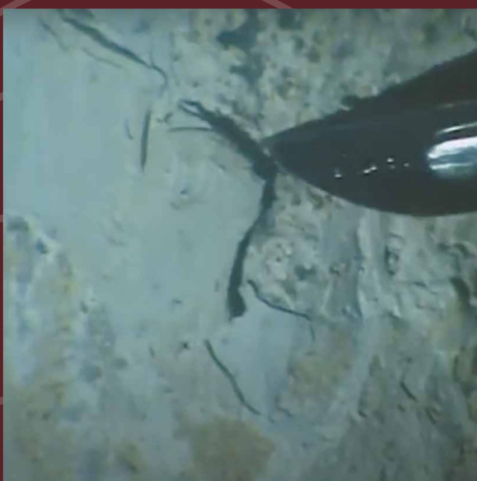
Verwijderen dikke lagen kalk
